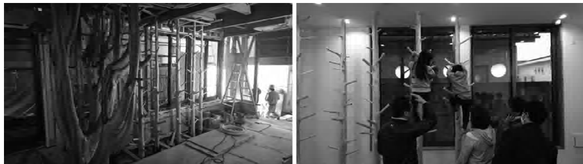
▲左：施工の様子 右：保育者・施工者・設計者と園児代表が寄って検討する。
