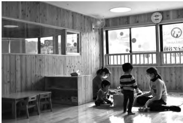
▲ 改修後の保育室。壁は杉板張り
