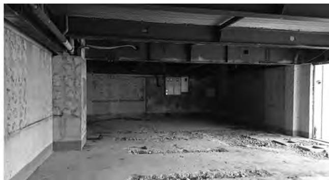
▲改修前の状況
