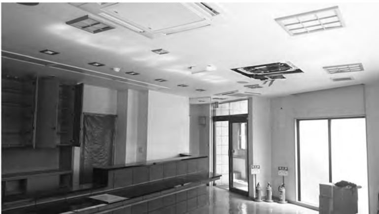
▲ 改修前の状況
