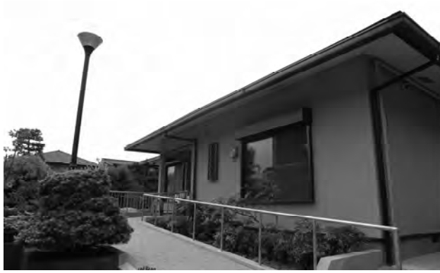
▲外観。増築したスロープが見える
